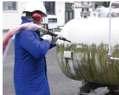
Подготовка поверхности при реставрации ёмкостей
