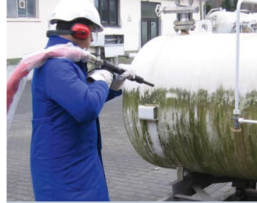
Tankların restorasyonunda yüzeyin hazırlanması
