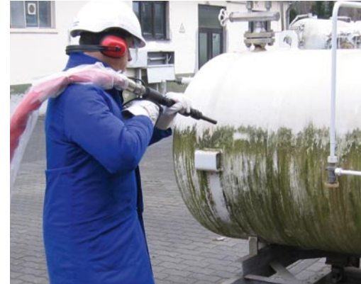
Restauration d'une citerne – Préparation de la surface
